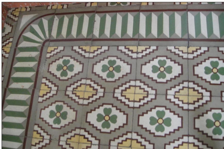
Figura 6: Piso original desde 1943
