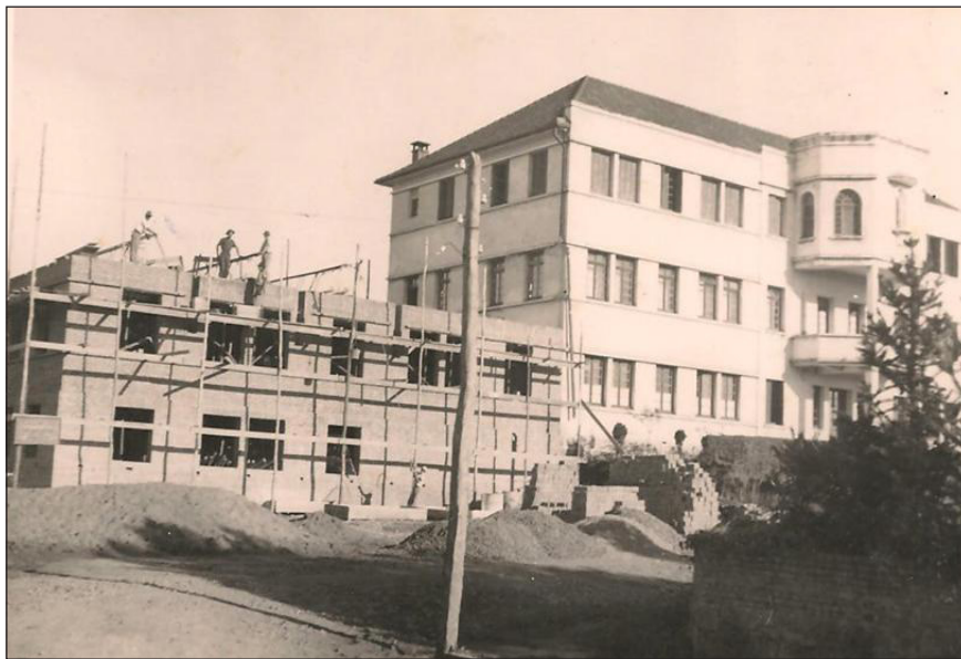
Figura 14: Ampliação do prédio do CNSL para a instalação do curso ginásial – Década de 1950.
