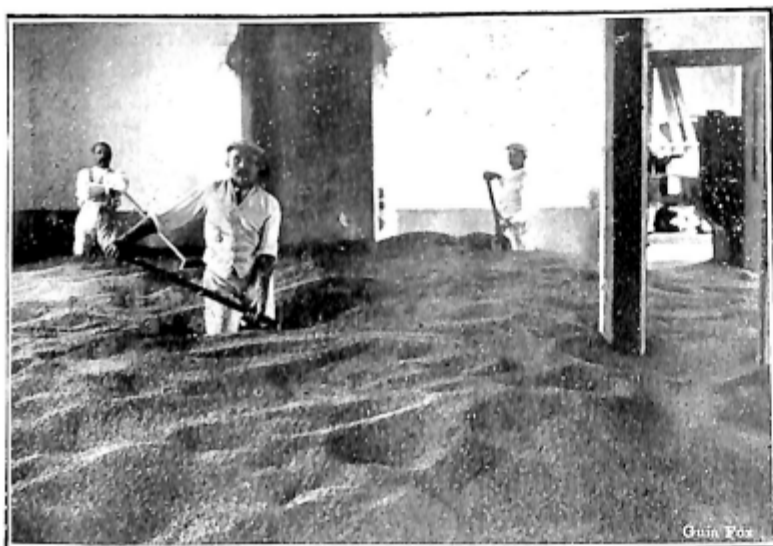
8.ª secção. Parte do depósito de trigo em grão. Moinho Aristides Germani.
