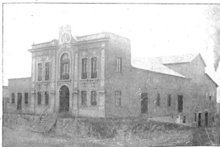
Edificio onde funciona o Club Juvenil
