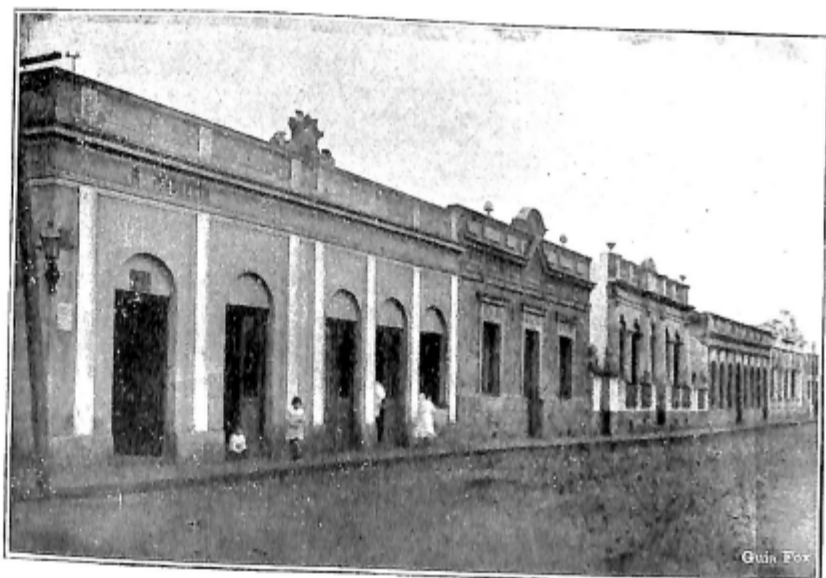
Trecho de rua em S. Borja ( rua principal )
