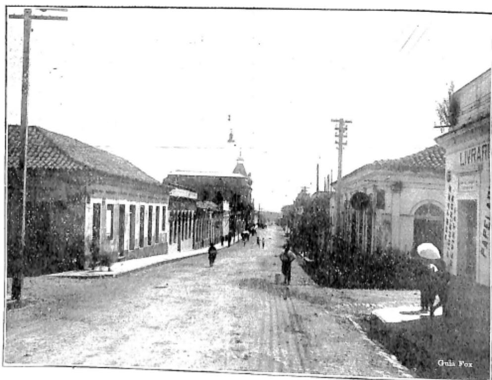
Trecho da rua Rivadavia Corrêa
