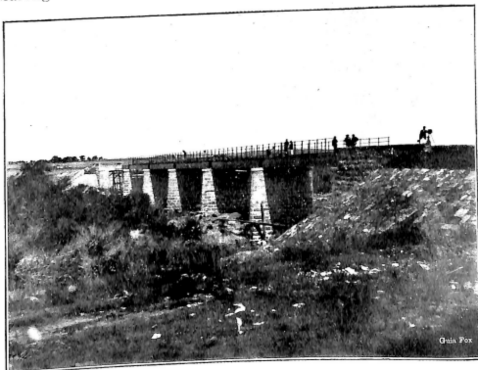
Ponte sobre o rio Caverá — Alegrete
