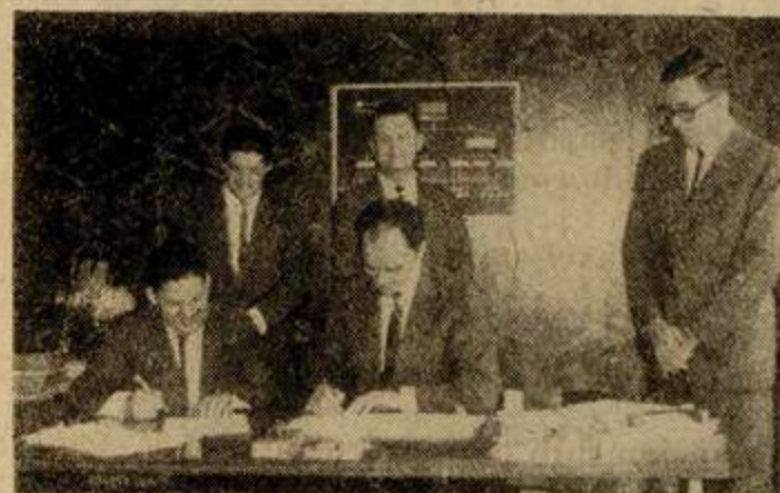
Flagrante da assinatura do contrato para fornecimento de 200 Casas pré-fabricadas. — Sentados sr. Idorly Zatti, Diretor da MADEZATTI e Eng. Iraci Louzada de Abreu, Vice-Presidente da CEEE. - De pé: Dr. Edemir Zatti, Eng. Hans Sille, coordenador do Passo Real e Eng. Holtermann Neto, Diretor Técnico da CEEE.
