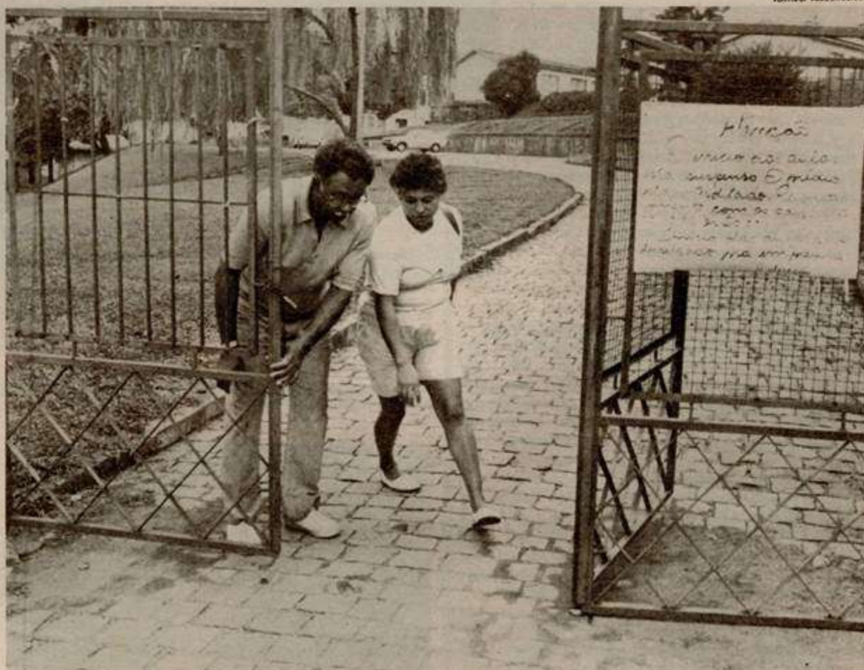
Prédio da Escola Estadual João Triches permanece interditado por falta de segurança: mais de 1.000 alunos ficam sem aula
