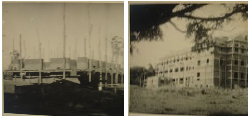
Figura 4 – Construção do prédio escolar do Ginásio Pio XII, década de 1950
