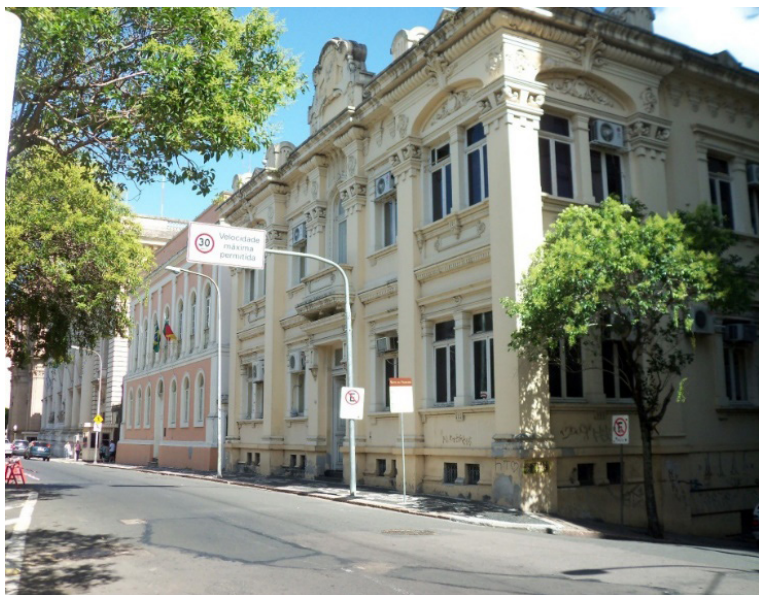
Figura 3 – Prédio da antiga Escola Complementar (1921-1936)
