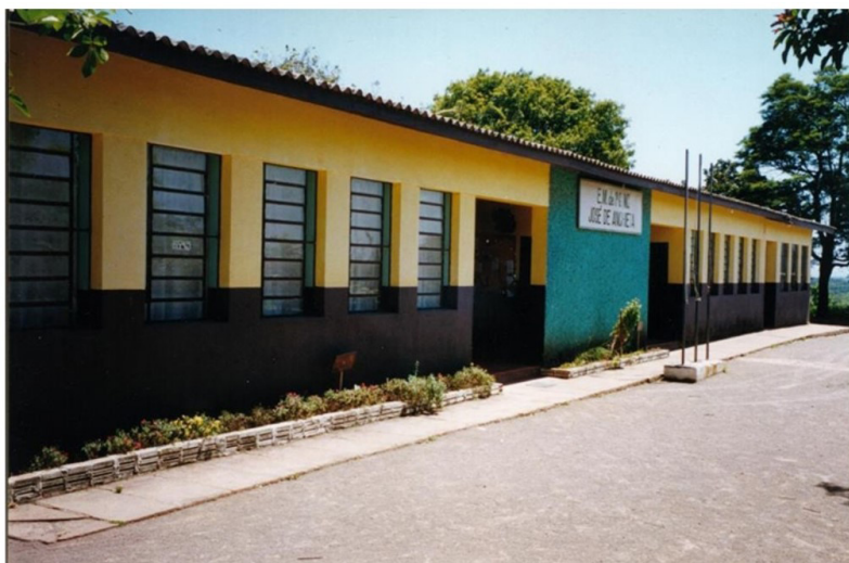
Figura 3 – Visão frontal do prédio da Escola, em 1984
